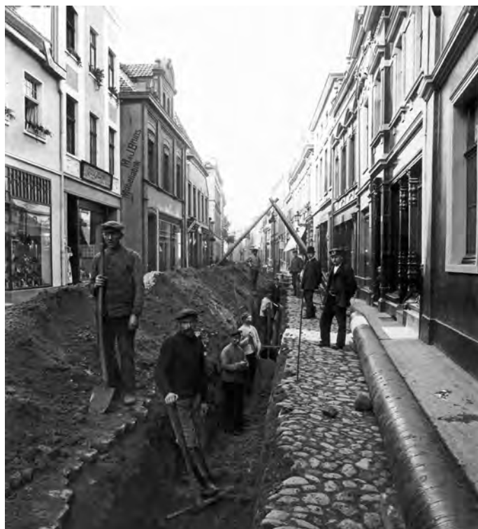
Das Verlegen der Wasserleitung, wie hier in der Nordstraße, war 1912 noch mit harter körperlicher Arbeit verbunden.
